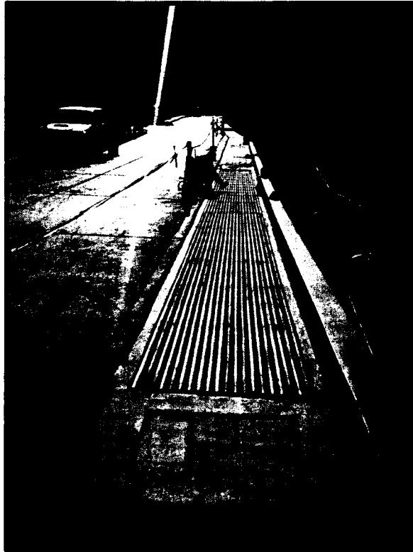
Rejilla Metálica y Sardinel de Protección.
